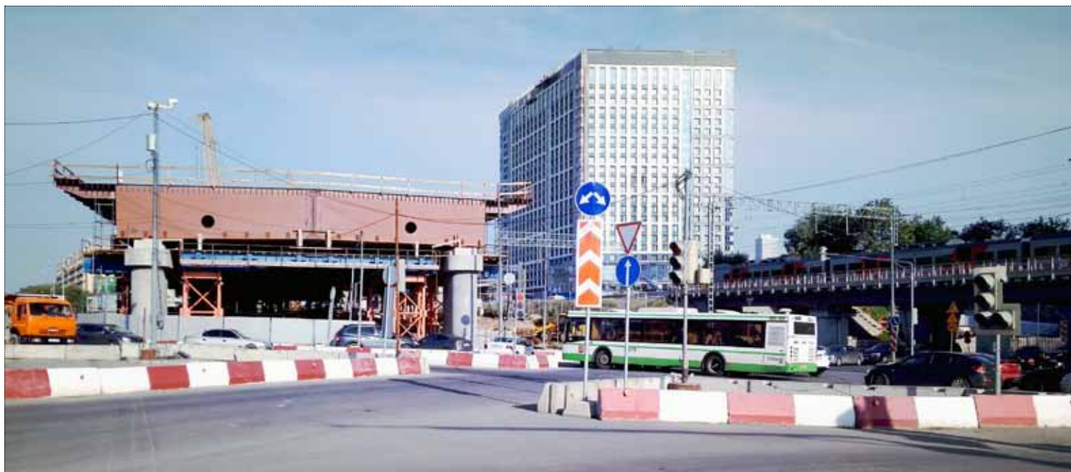
Строительство эстакады на проезде Серебрякова у станций метро и МЦК «Ботанический сад». Фото автора, август 2020 года
